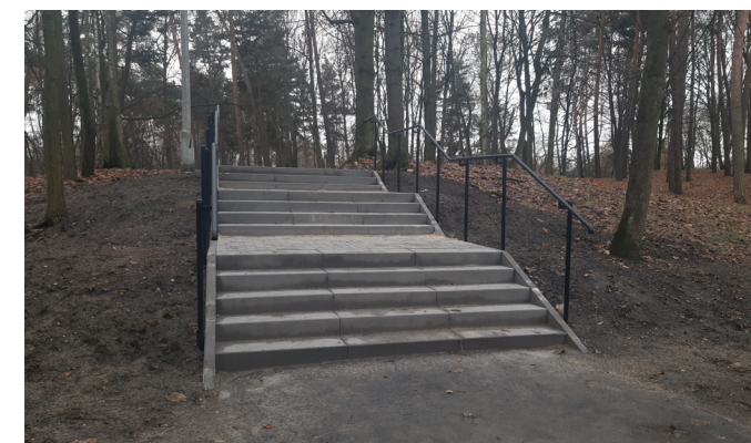
Wyremontowane schody w Parku Solvay
